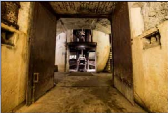
Tunnels en installaties in het Fort Douamont
